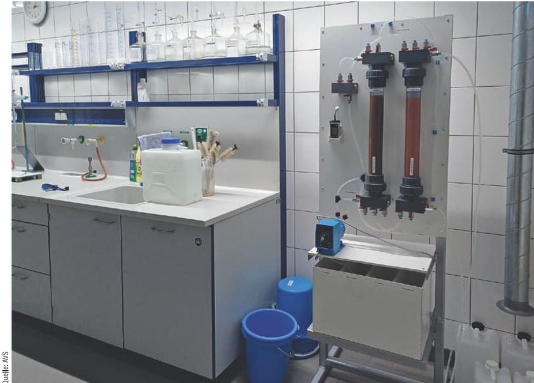
Abb. 6: Blick auf die fertiggestellte Deionisierungsanlage bei der Erstbefüllung mit Anionen- und Kationharzen im Fachkabinett Labor.
