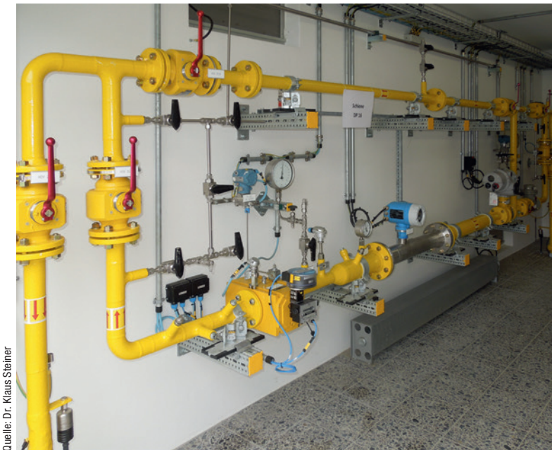
Abb. 2: Messanlage zur eichpflichtigen Messung von Wasserstoff in der Power-to-Gas-Anlage Falkenhagen
